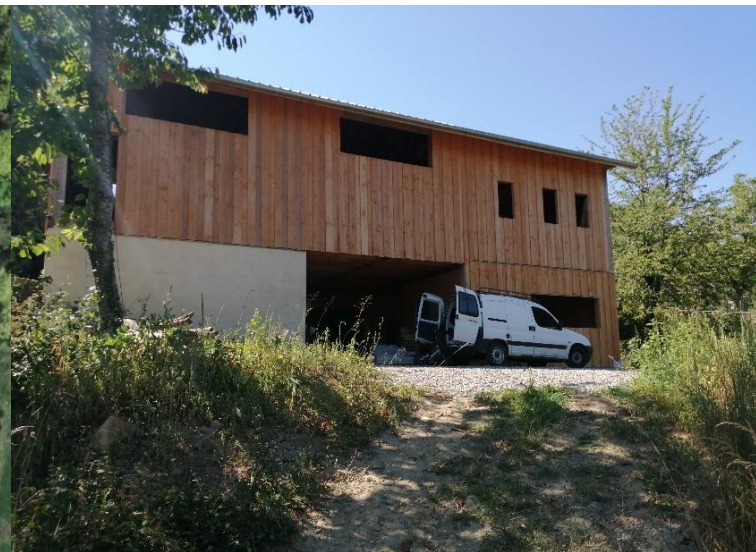
Bâtiment agricole en construction
